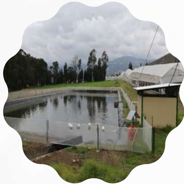
Captación de agua lluvia
